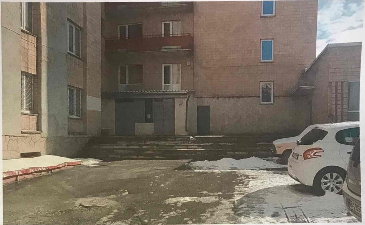
Рис. 4. Загальний вигляд сходів біля входу в гуртожиток
