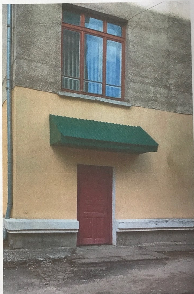
Рис. 7. Загальний вигляд запасного входу в навчальний корпус
