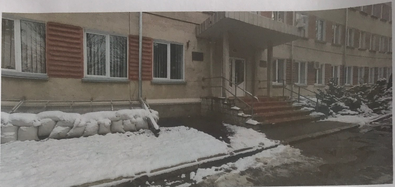
Рис. 5. Загальний вигляд сходів біля входу в навчальний корпус №3
