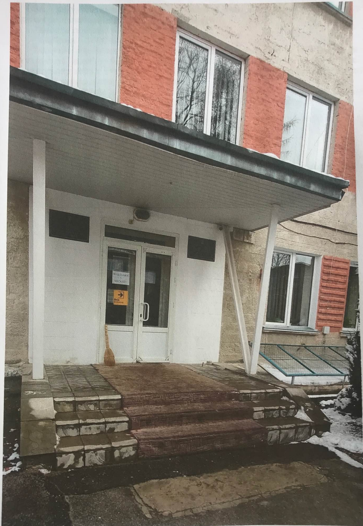
Рис. 4. Загальний вигляд сходів біля входу в навчальний корпус
