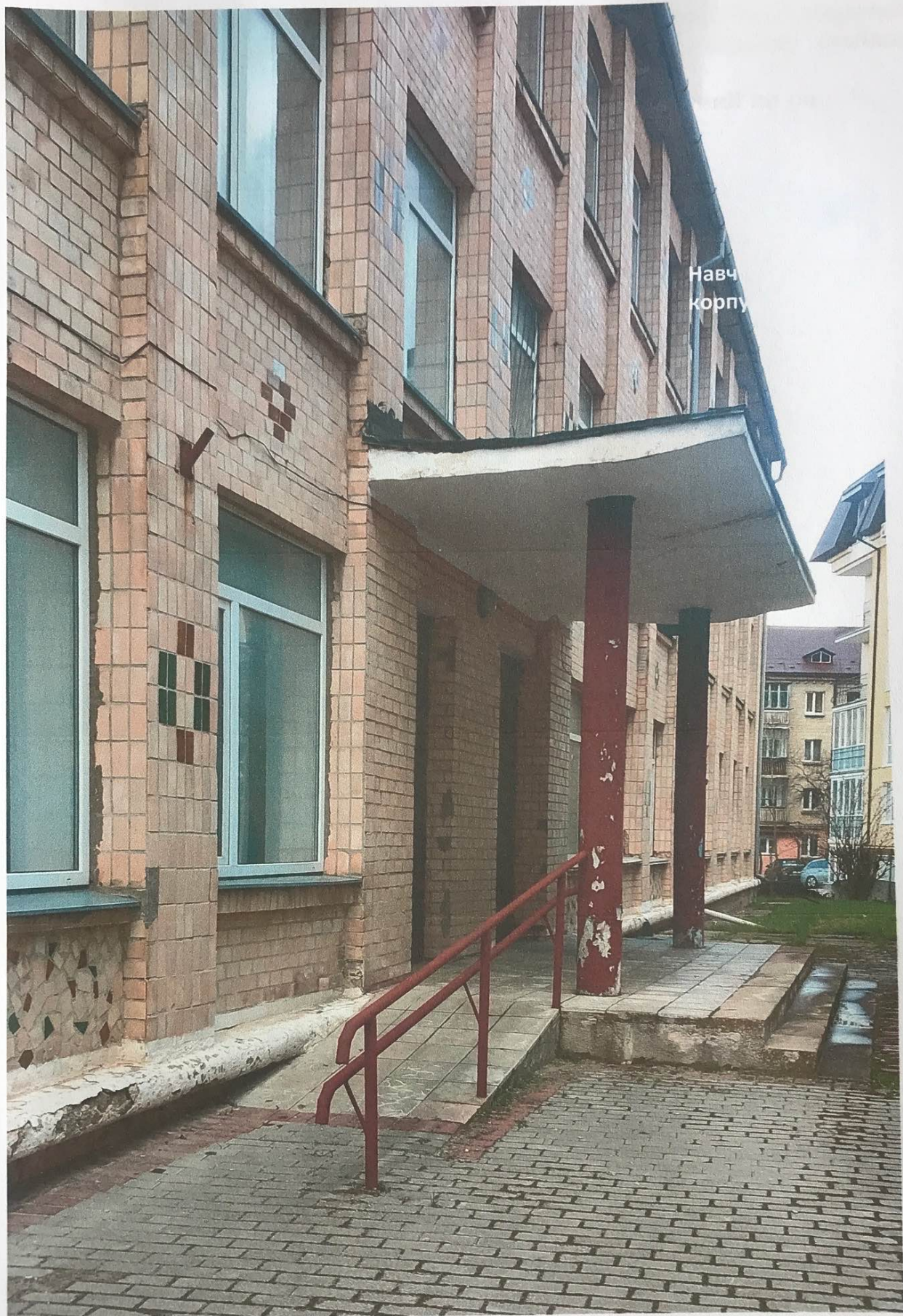
Рис. 3. Загальний вигляд пандусу входу в навчальний корпус №7
