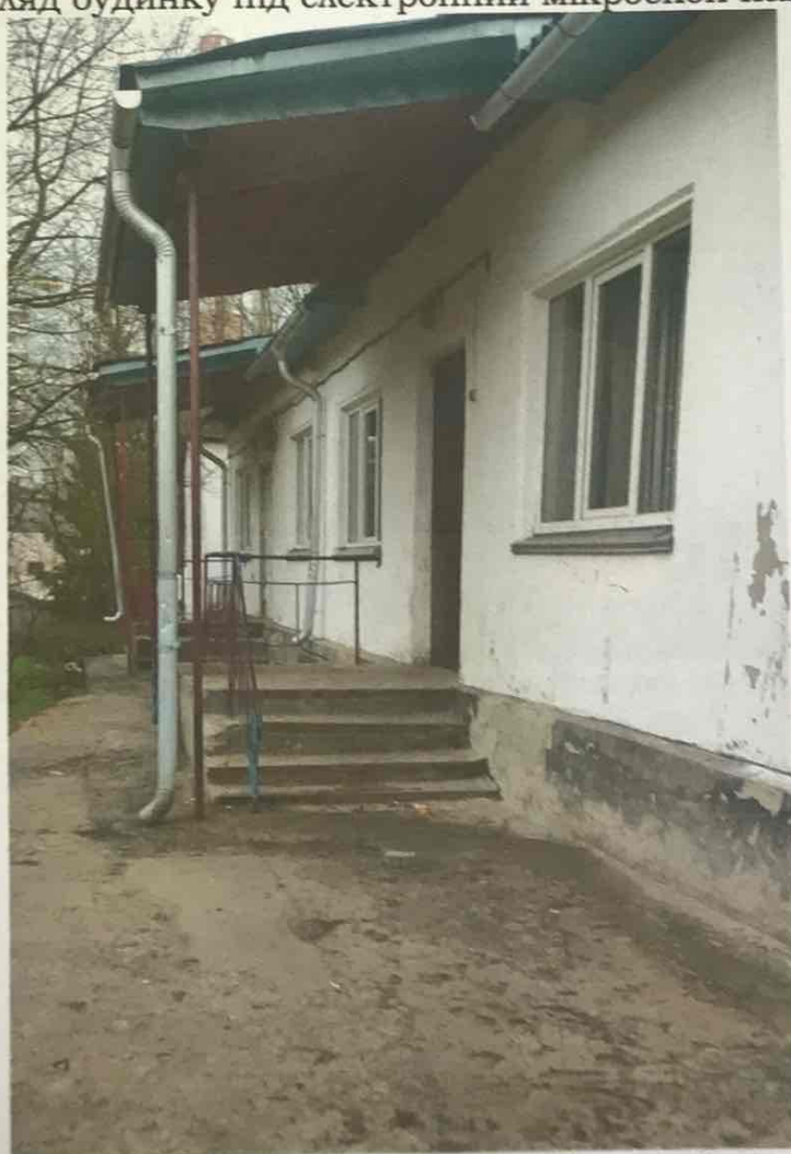
Рис. 4. Загальний вигляд будинку під електронний мікроскоп
