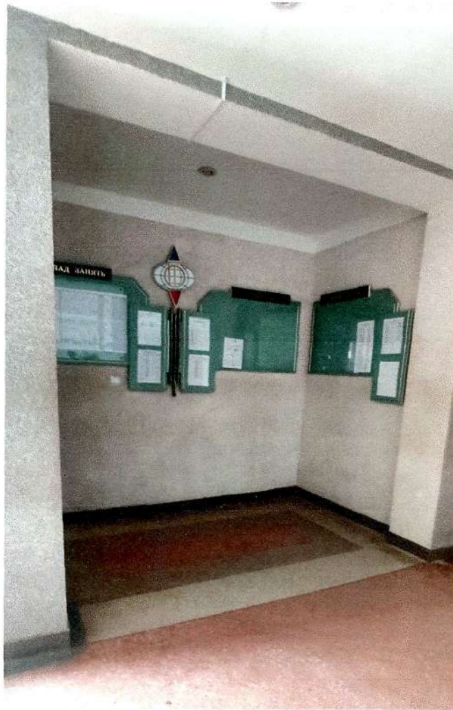
Рис. 12. Ніша на місці колишнього тамбуру перед входом у кабину ліфта. Існує на кожному поверсі будівлі головного корпусу
