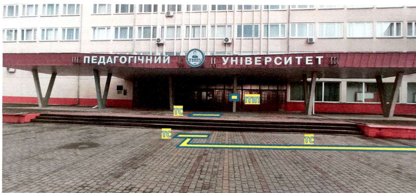
Рис. 26. Рекомендований шлях руху МГН з місцями встановлення ТС, ІТП перед входом в головний корпус
