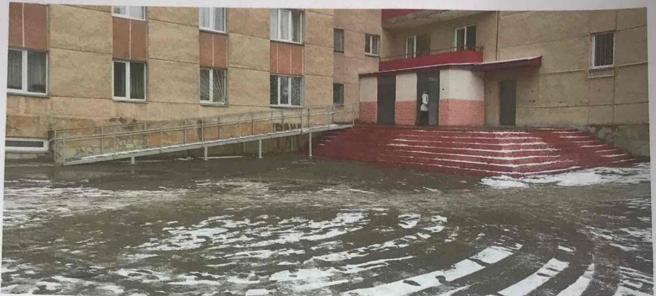
Рис. 5. Загальний вигляд сходів входу в гуртожиток
