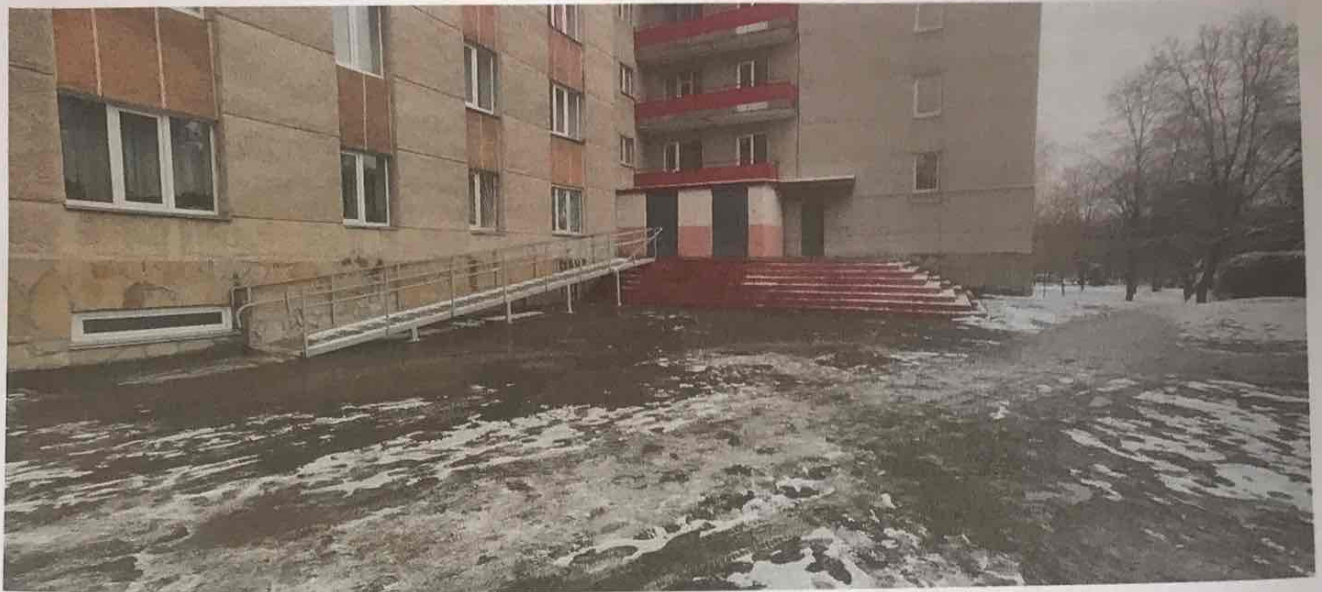
Рис. 6. Загальний вигляд пандуса біля центрального входу в гуртожиток
