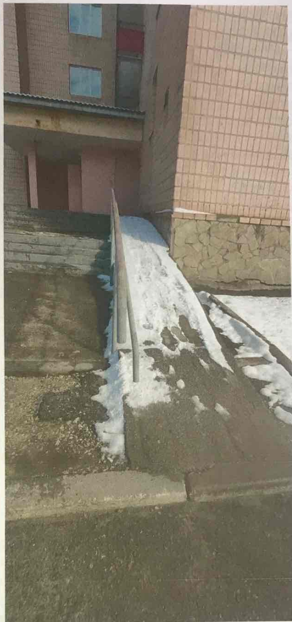
Рис. 6. Загальний вигляд пандуса біля центрального входу в гуртожиток
