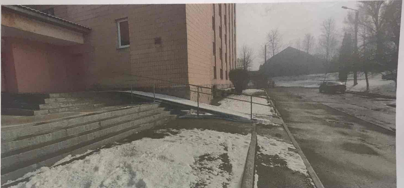
Рис. 5. Загальний вигляд сходів входу в гуртожиток
