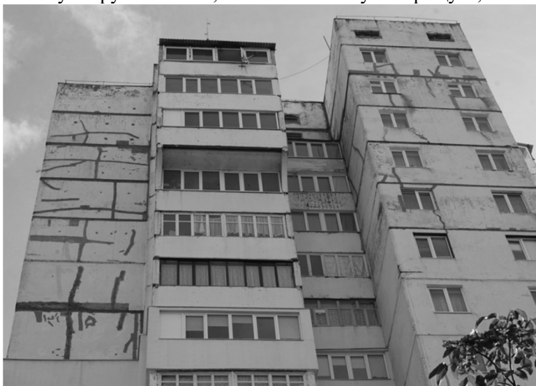
Вул. Лучаківського (16-ти поверхівка)
