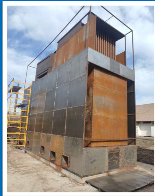
Монтаж теплогенератора потужністю, 6 мВт
