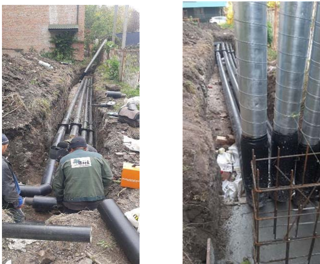
Рис. 10. 2. Капітальний ремонт теплотраси
