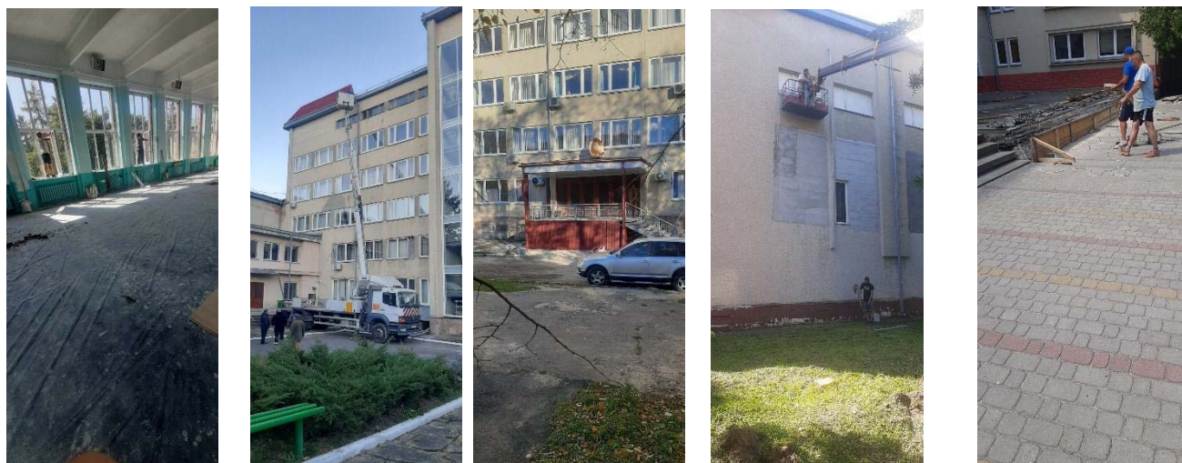
Рис. 10.5. Ремонт спортивного залу та головного корпусу
